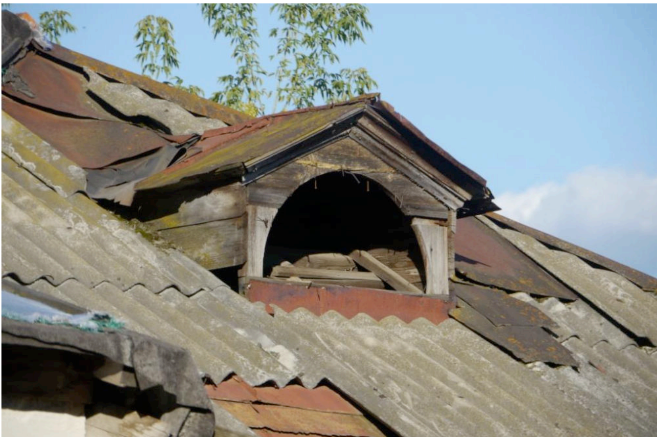
Фото 11. Слуховое окно на западной вальме крыши главного дома.
