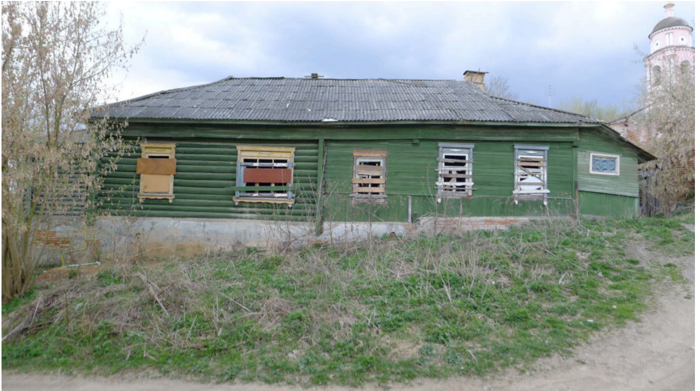
Фото 7. Главный дом. Восточное крыло. Восточный фасад.
