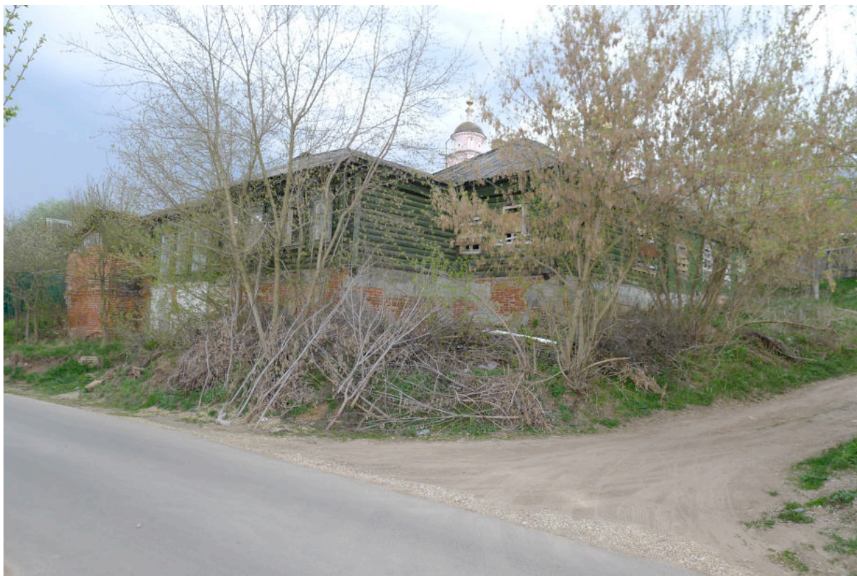
Фото 1. Вид главного дома с юго-востока.
