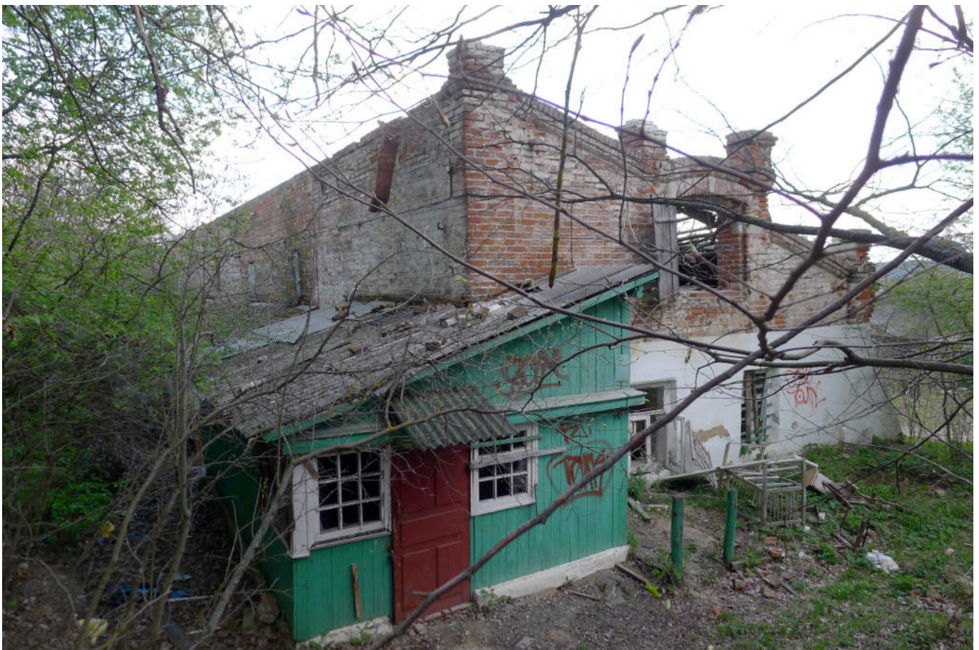
Фото 18. Конюшня. Вид с северо-запада.
