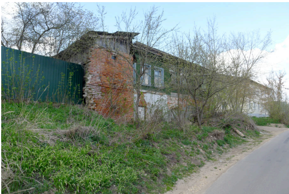
Фото 2. Вид главного дома с юго-запада.
