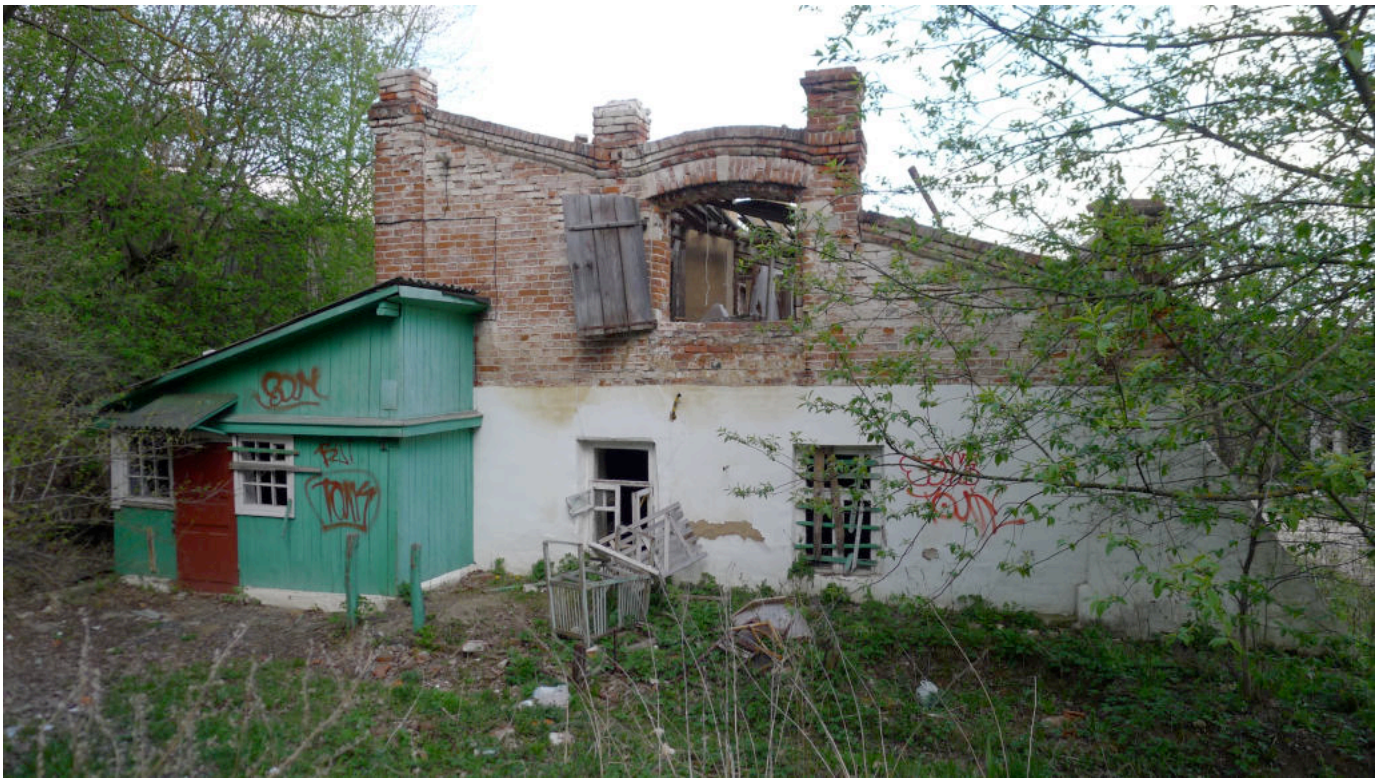
Фото 17. Конюшня. Западный фасад.
